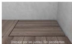
Drenaje por las juntas. Sin pendientes
